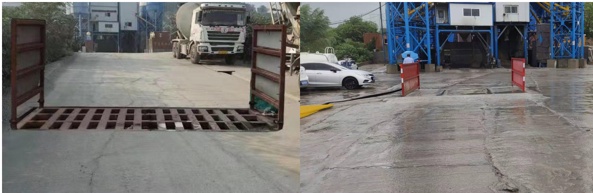
图3-1该项目洗车平台
