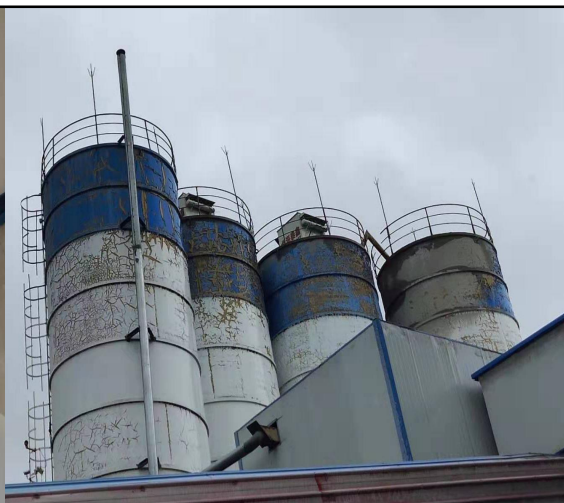
图 3-8 搅拌机除尘器排气筒
